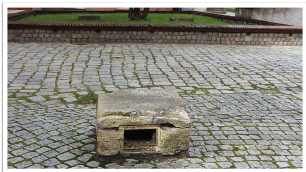
Fot. 8-10. Wyloty czerpni powietrza i ławki
