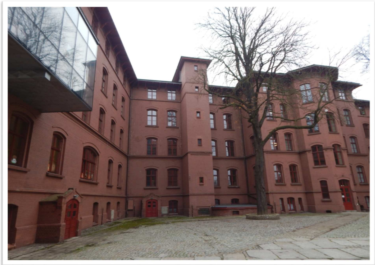
Fot. 5. Widok na zespół wejściowy – elewacja północna.
