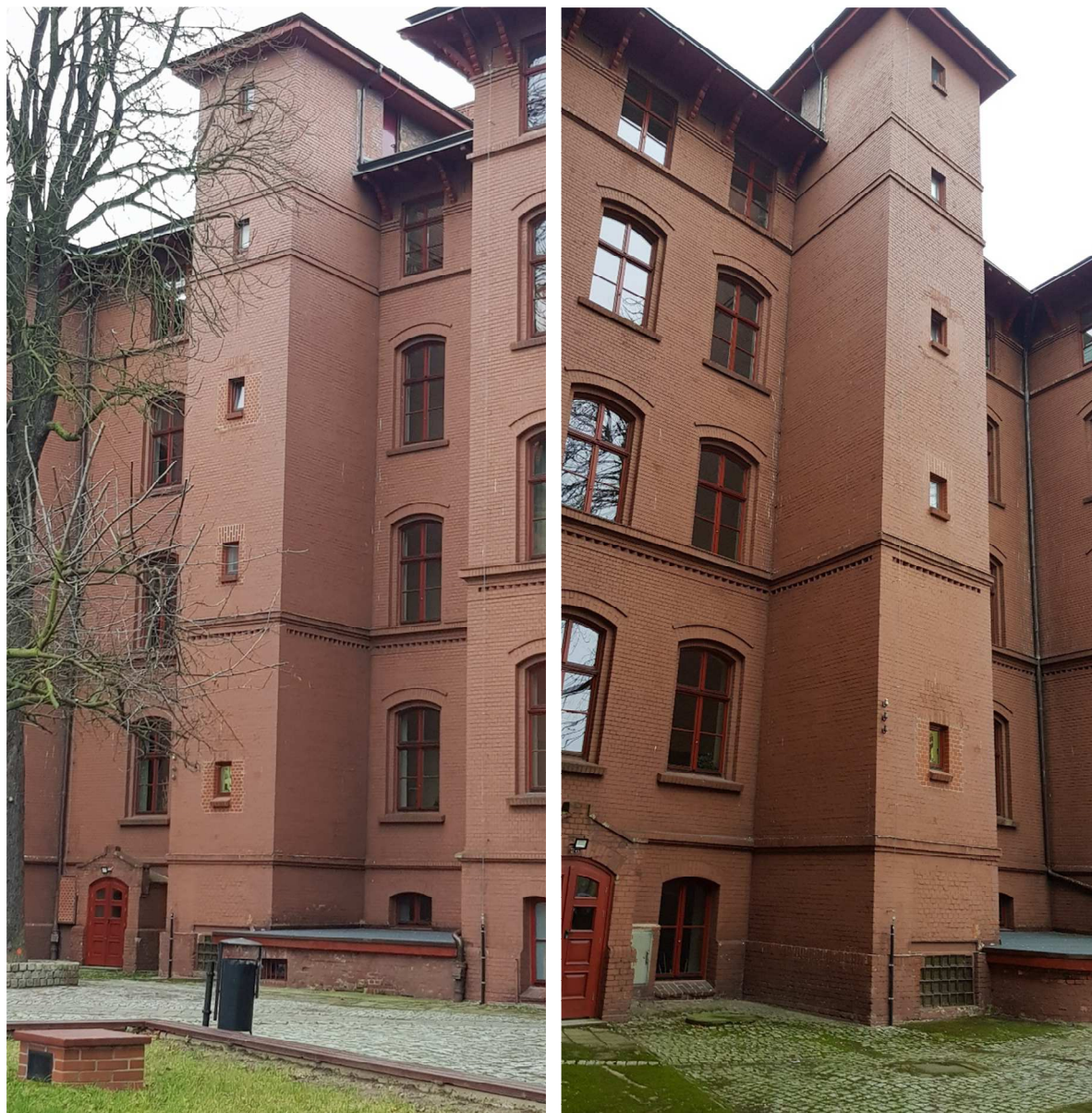
Fot. 11 – 12 Widok elewacji bocznych szybu windowego
