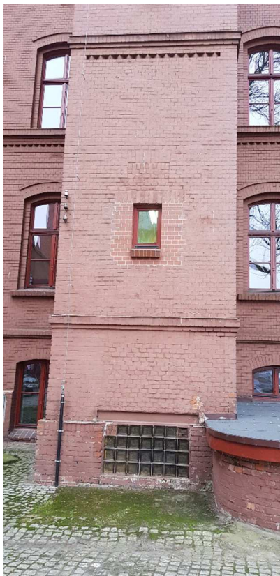
Fot. 8-10 Widok miejsca zamurowanych drzwi wejściowych, drzwi do szybu na parterze i I piętrze.
