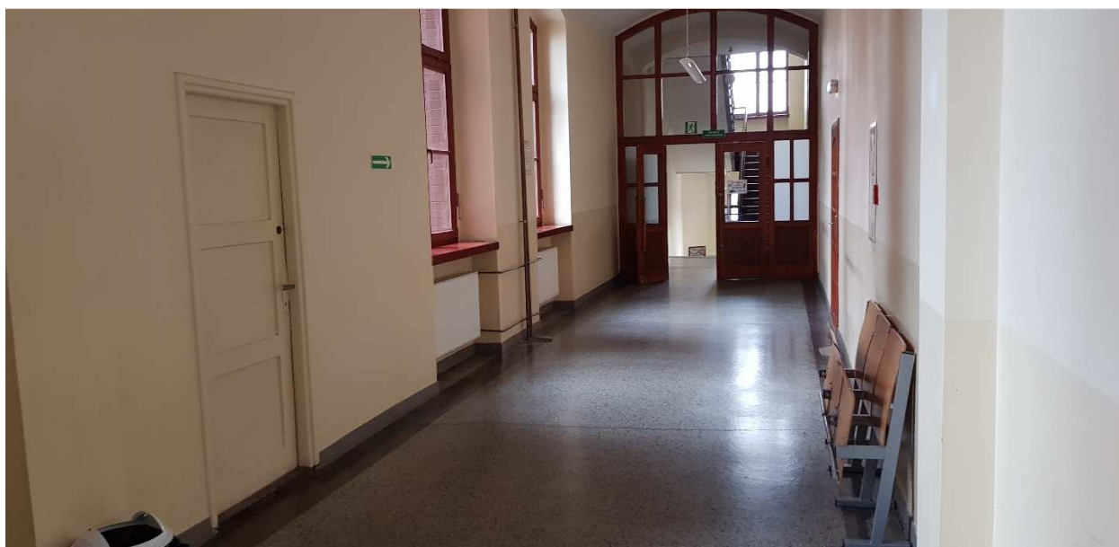
Fot. 6-7. Widok drzwi szybu windy na korytarz parteru i I piętra.
