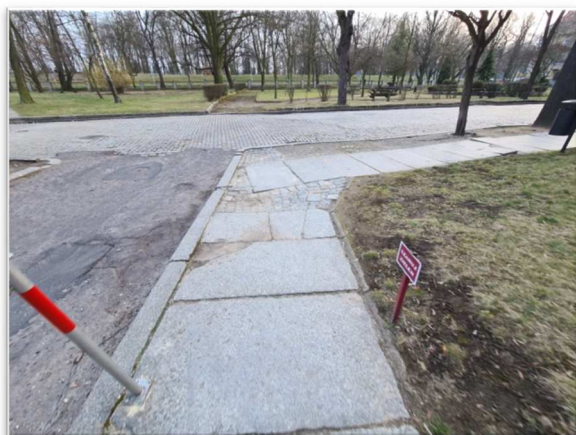
Fot. 20. Liczne pęknięcia płyt chodnikowych.
