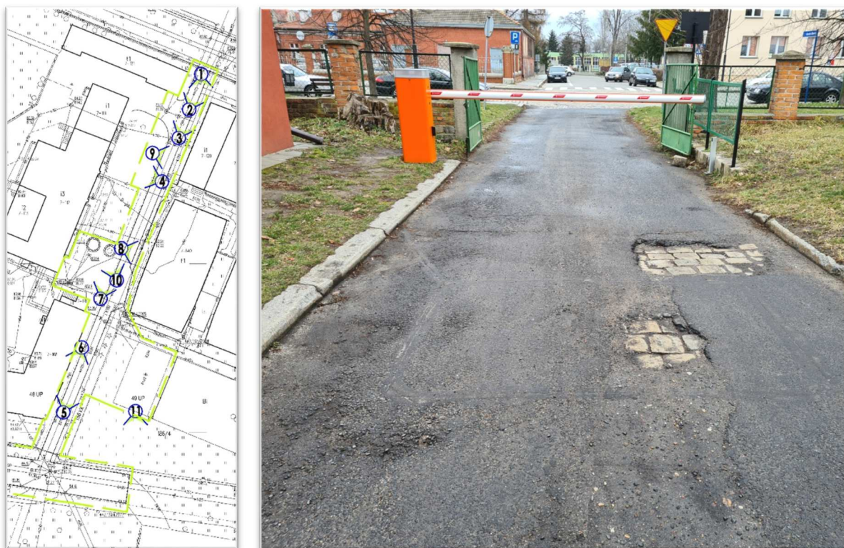
Fot. 1. Wjazd od strony północnej. Krawężnik granitowy od strony garaży, obrzeże z kostki granitowej po stronie wschodniej bramy wjazdowej. Liczne uszkodzenia i ubytki.
