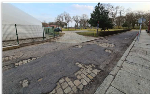
Fot. 10 - 11. Wjazd na miejsce parkingowe przy kortach tenisowych. Widoczne ubytki, liczne uszkodzenia nawierzchni.
