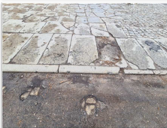
Fot. 6-9. Obrzeże z płyt granitowych. Liczne spękania i uszkodzenia. Krawężniki miejscowo uszkodzone i wyszczerbione.
