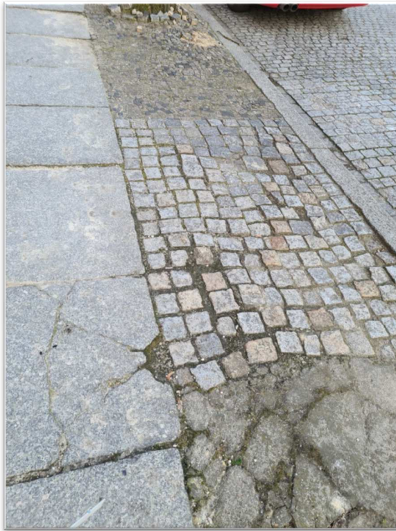
Fot. 22-23. Widoczne ubytki, liczne uszkodzenia płyt chodnikowych.
