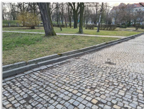
Fot. 14 - 19. Nawierzchnia z kostki granitowej. Widoczne ubytki, liczne uszkodzenia nawierzchni, zapadliny. Krawężniki z wykwitami, zawilgocone.
