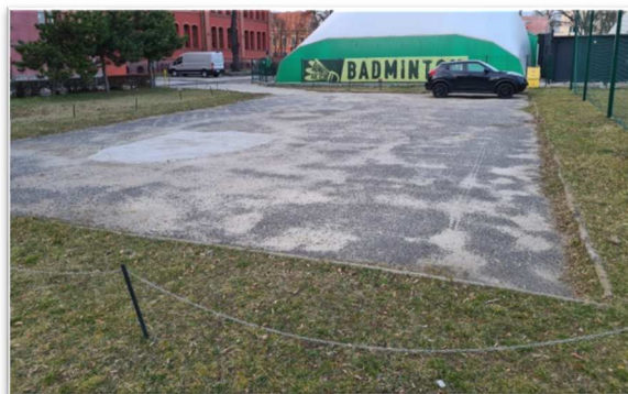
Fot. 10 - 11. Wjazd na miejsce parkingowe przy kortach tenisowych. Widoczne ubytki, liczne uszkodzenia nawierzchni.
