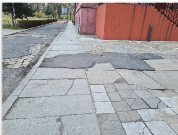
Fot. 4-5. Nawierzchnia asfaltowa - liczne spękania, ubytki i uszkodzenia powierzchniowe.
