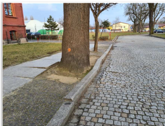
Fot. 21. Miejscowe ubytki, nierówności nawierzchni.
