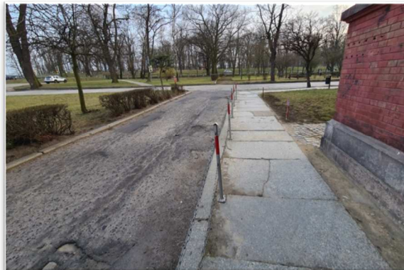
Fot. 4-5. Nawierzchnia asfaltowa - liczne spękania, ubytki i uszkodzenia powierzchniowe.
