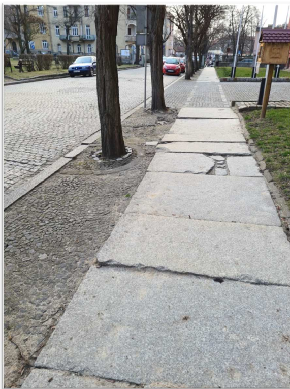
Fot. 22-23. Widoczne ubytki, liczne uszkodzenia płyt chodnikowych.
