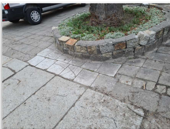
Fot. 6-9. Obrzeże z płyt granitowych. Liczne spękania i uszkodzenia. Krawężniki miejscowo uszkodzone i wyszczerbione.
