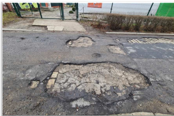
Fot. 4-5. Nawierzchnia asfaltowa - liczne spękania, ubytki i uszkodzenia powierzchniowe.
