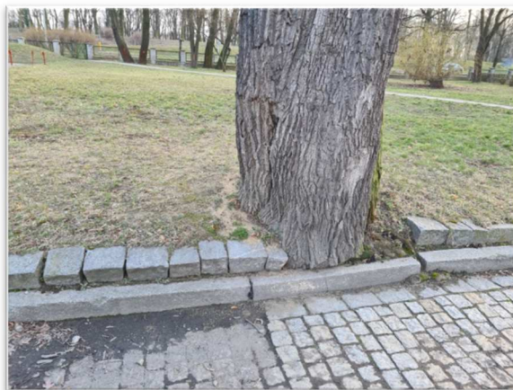
Fot. 14 - 19. Nawierzchnia z kostki granitowej. Widoczne ubytki, liczne uszkodzenia nawierzchni, zapadliny. Krawężniki z wykwitami, zawilgocone.
