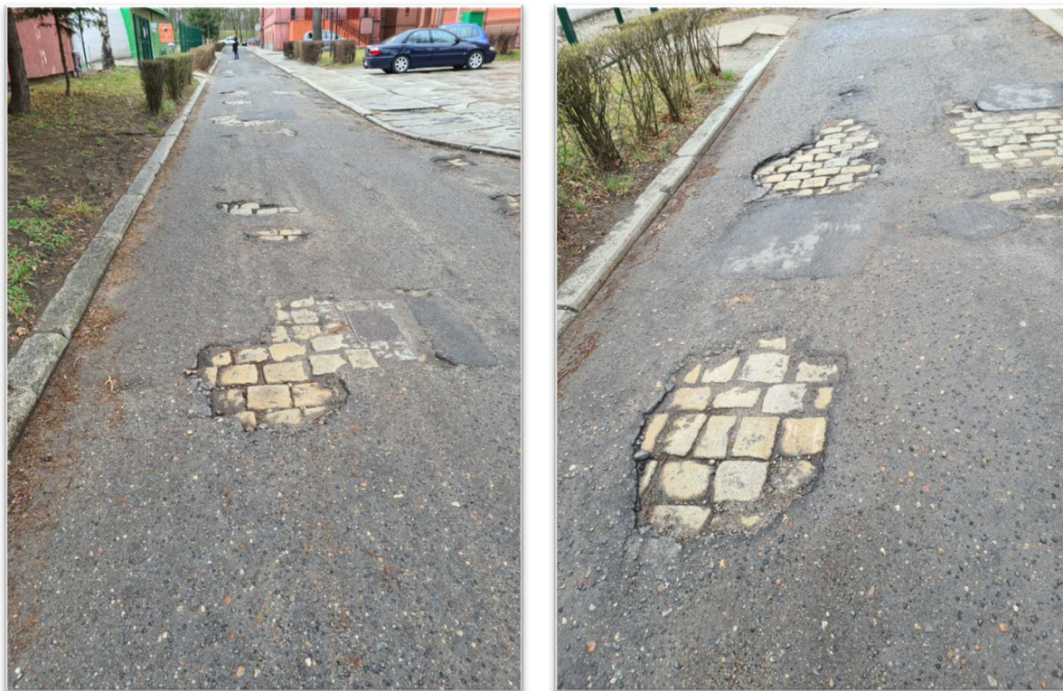
Fot. 2 - 3. Uszkodzona nawierzchnia asfaltowa. Widoczne ubytki i warstwy nawierzchni z kostki granitowej.
